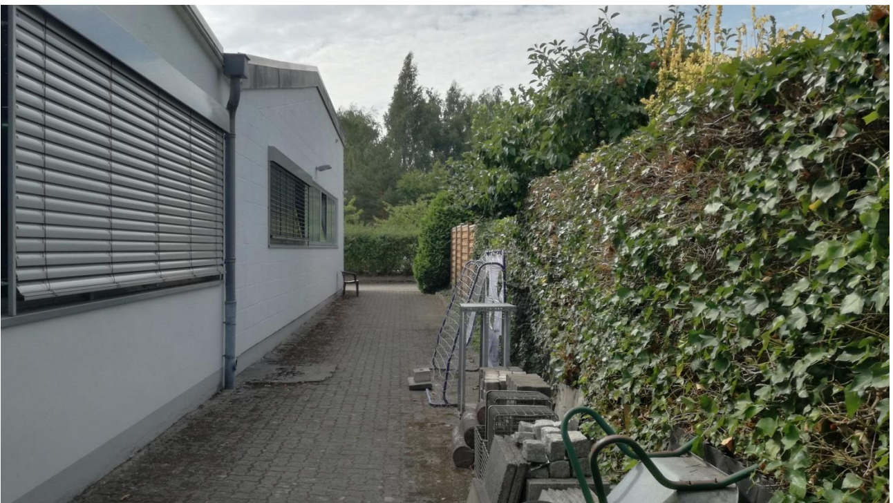
Gebäude ohne Nischen, Dachkante nicht zugänglich und Efeu-Heckenstruktur, bleibt erhalten
